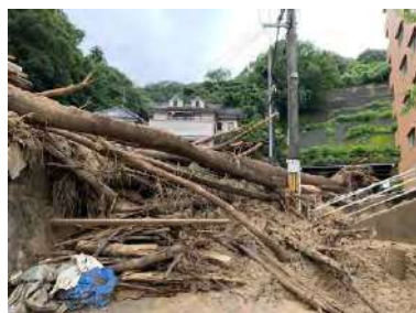
豪雨による土砂災害
