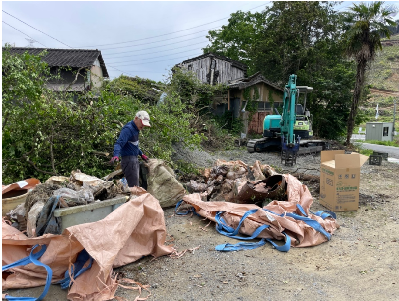
本みんか建設に向けた整備の様子
