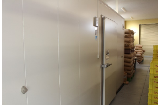
2 坪プレハブ冷蔵庫：ドア横と室外機に表示
