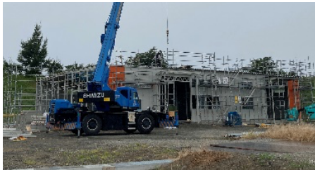
9/8 センター建設現場 (倉庫部分)
