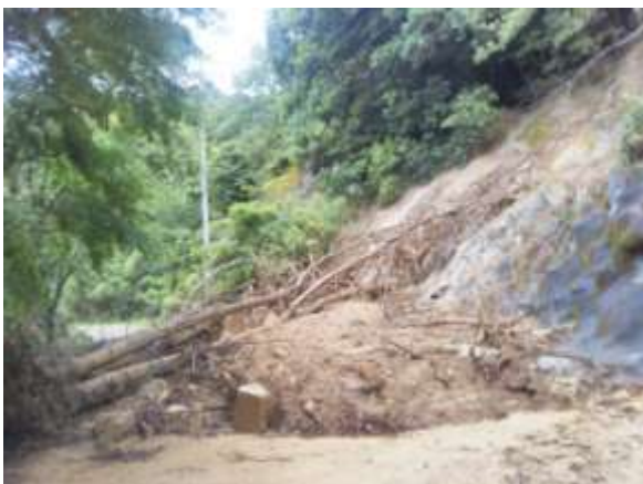
植樹地につながる道路も至る所で土砂崩れが発生
