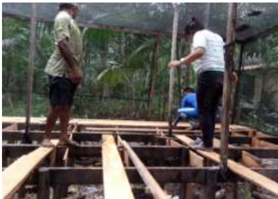
(写真左) 建設中の苗畑施設、氾濫原にあることから高床式である。 (写真右) 完成した苗畑施設、苗床部はセメントで覆われている。
