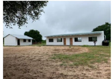
▶修繕完了したシニャングアニーネ小学校校舎
