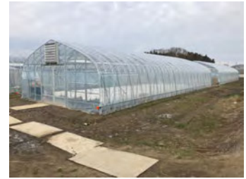
再建したビニールハウス
