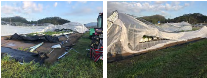
全壊したビニールハウス
