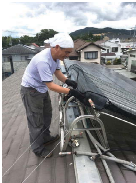
22年前に設置された太陽熱温水器の修繕工事にも対応。無事に継続使用できました。（近江八幡市）
