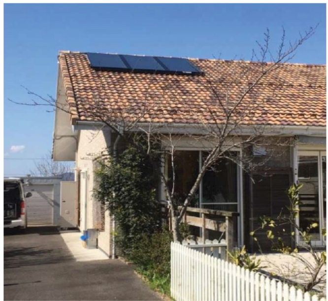
グループホームの入浴用にソーラーシステム(太陽熱利用機器)を設置しました(近江八幡市)
